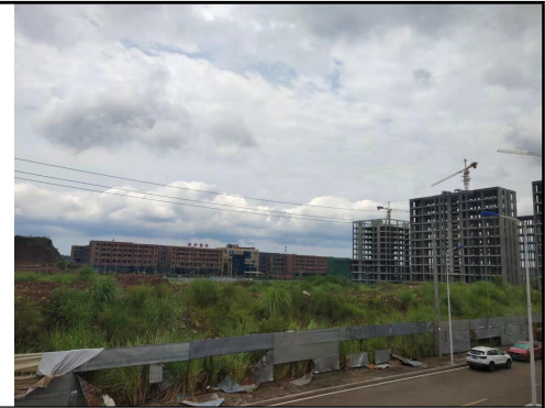
图 1-2 项目西侧待建空地
