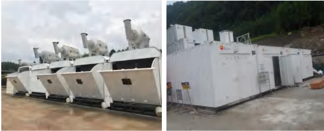
图 5.3-4 类比建设单位其他井站柴油机、发电房噪声防治措施实照
