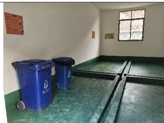
危废暂存间内部
