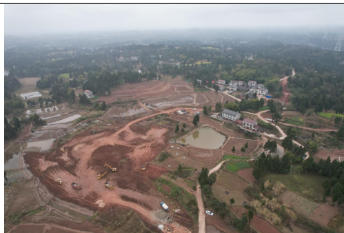
项目依托高石 009-H37 井建设的井场实施（高石 009-H37 井正在实施钻前工程）
